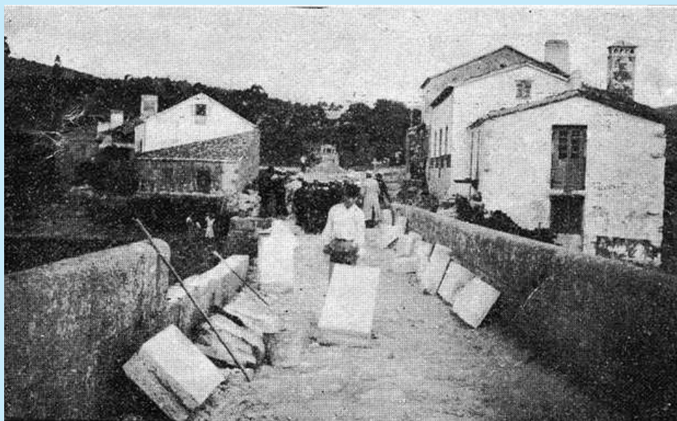
Obras en Ponte Nafonso, 1918 (revista Vida Gallega )
