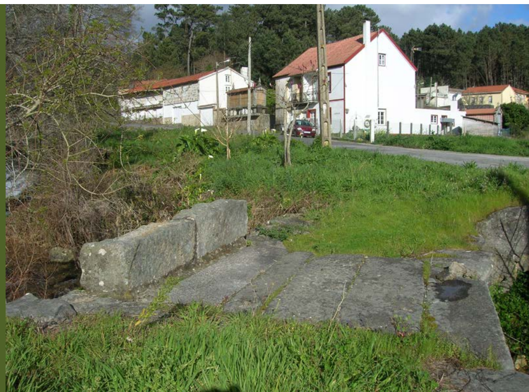
Foto 1. Parte superior da pontella e, no fondo, lugar onde estaba a capela de Santo Amaro.
