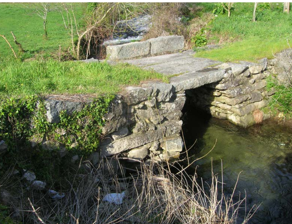
Foto 2. Ponte entre Bendimón e Aspera.
